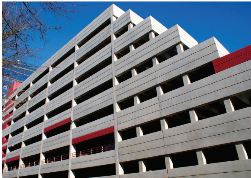
Fot. 1. Parking wielopoziomowy z betonowych elementów prefabrykowanych
