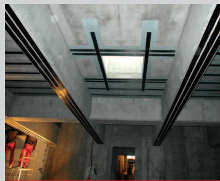
Wzmocnienie taśmami Sika®CarboDur® ze względu na zwiększone obciążenia i otworowanie stropu
