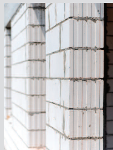
Ściana zewnętrzna zbudowana z bloczków silikatowych
