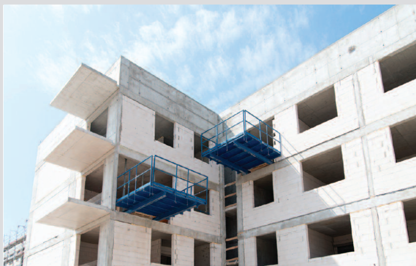
Budynek wielorodzinny do budowy którego, wykorzystano bloczki silikatowe. Z bloczków wapienno-piaskowych zbudowano zarówno ściany zewnętrzne, jak i wewnętrzne
