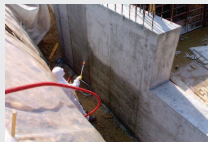
Przegroda betonowa w konstrukcji podziemnej
