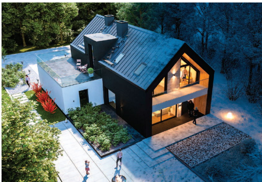
Efektywność energetyczna zaczyna się od obudowy budynku. Dzięki temu zyskamy małe straty ciepła zimą i ograniczenie przegrzewania latem
