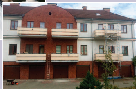
Izolacja balkonów gotową masą THERMOHIT®, z której wykonano powłokę refleksyjną, pozwoliła wyeliminować mostki termiczne
