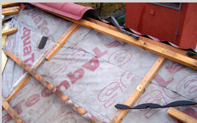
Fot. 5. Dach z fotografii 4 w czasie demontażu pokrycia. Pierwsza od kalenicy łata odpadła sama, a dwie zostały zdemontowane. Widać uszczelnienie gąsiorów
