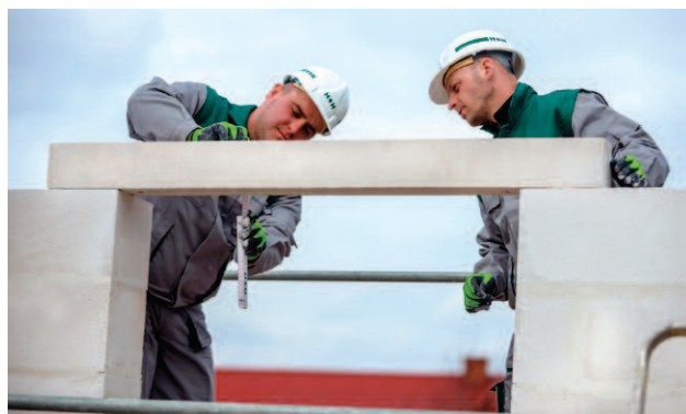
Osadzanie na ścianie prefabrykowanego, systemowego nadproża ze zbrojonego betonu komórkowego Fot. H+H Polska Sp. z o.o.
