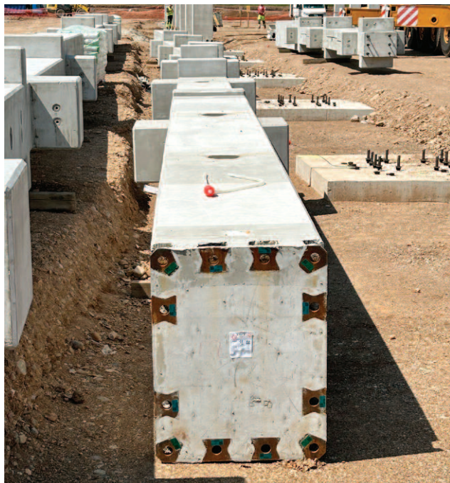
Fot. 1. Podpory słupowe SiDi i CoRni w podstawie słupa zastosowane w inwestycji Amazon
