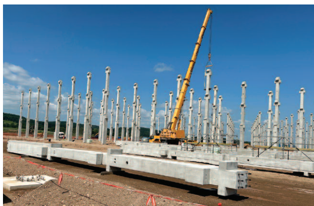
Fot. 3. Budowa Amazon, Dobromierz
