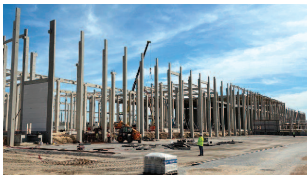
Fot. 2. Budowa Biedronki w Opcznie
