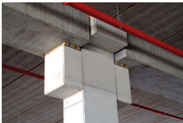
Fot. 4. Calenberg podkład warstwowy Q (grubości 40 mm) zastosowany w inwestycji Amazon
