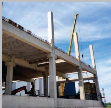
Fot. 5. Słupy żelbetowe do hal prefabrykowanych
