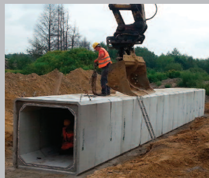
Fot. 6. Przepust skrzynkowy – przejście dla zwierząt pod drogą
