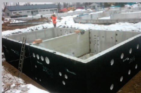
Fot. 2. Składana komora żelbetowa
