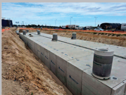
Fot. 1. Zbiornik retencyjny dwuszeregowy o pojemności ok. 1200 m 3
