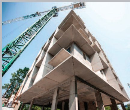
Fot. 4. Balkony prefabrykowane
