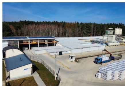
ZAKŁAD BETONÓW W LIPIU
