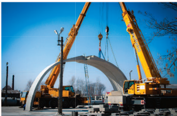
ZAKŁAD BETONÓW W KOLBUSZOWEJ - MONTAŻ ELEMENTÓW ŁUKOWYCH
