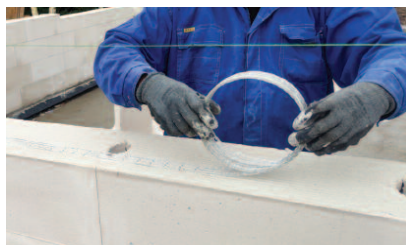
Fot. 1. Wzmocnienie muru za pomocą zbrojenia
