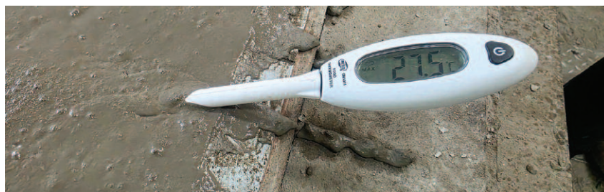
Fot. 2. Pomiar temperatury mieszanki betonowej przeznaczanej do prefabrykowanych wielowarstwowych ścian żelbetowych
