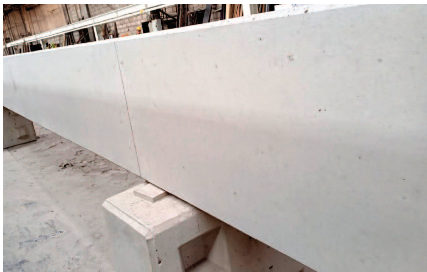
Fot. 1. Prefabrykowany słup żelbetowy wykonany z użyciem domieszki MC-EcoFlow 7041
