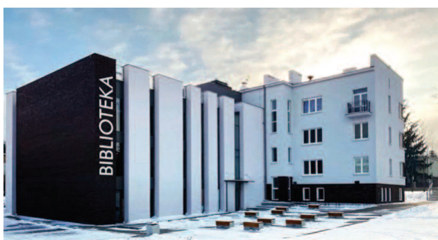
Photo 3. Public library in Nowy Dwór Mazowiecki [25] Fot. 3. Biblioteka Publiczna w Nowym Dworze Mazowieckim [25]
