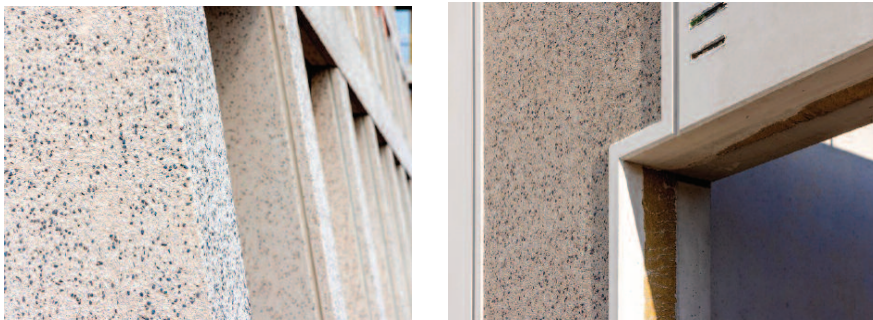
Fot. 2. Elementy prefabrykowane poddane piaskowaniu i płukaniu
