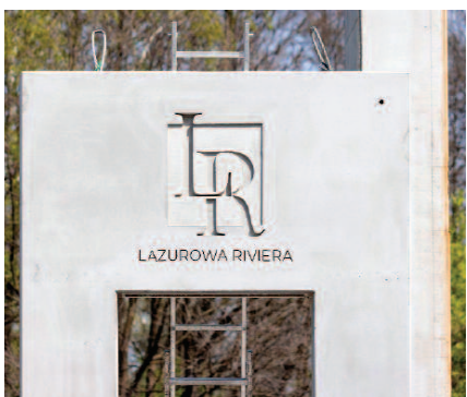
Fot. 5. Elementy prefabrykowane z powierzchnią uzyskaną za pomocą matrycy
