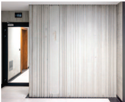
Fot. 4. Przykładowe powierzchnie uzyskane za pomocą matrycy
