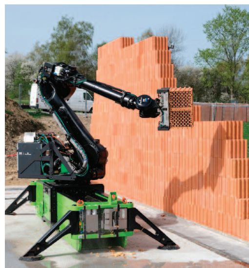
Robot murarski wznosi do 10 m 2 ściany w ciągu zaledwie godziny
