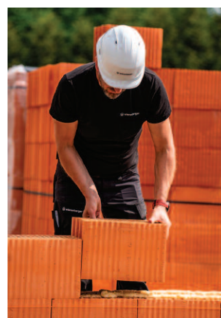
Pustaki Porotherm oraz pianoklej Dryfix tworzą przełomowy system cienkospoinowego wznoszenia muru na sucho
