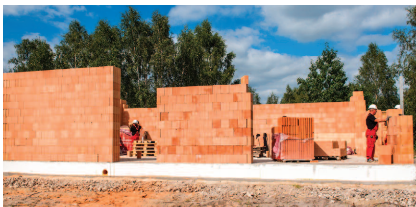
Ceramiczne pustaki Porotherm pozwalają wznosić ściany o bardzo dobrych parametrach cieplnych i akustycznych
