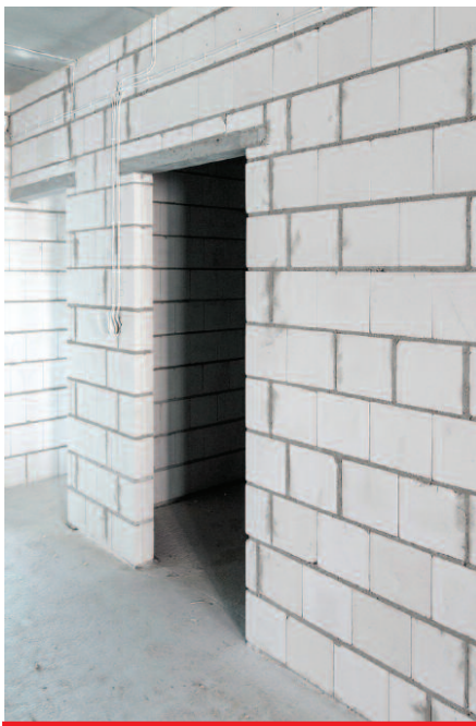
Ściana działowa wykonana z bloczków silikatowych
