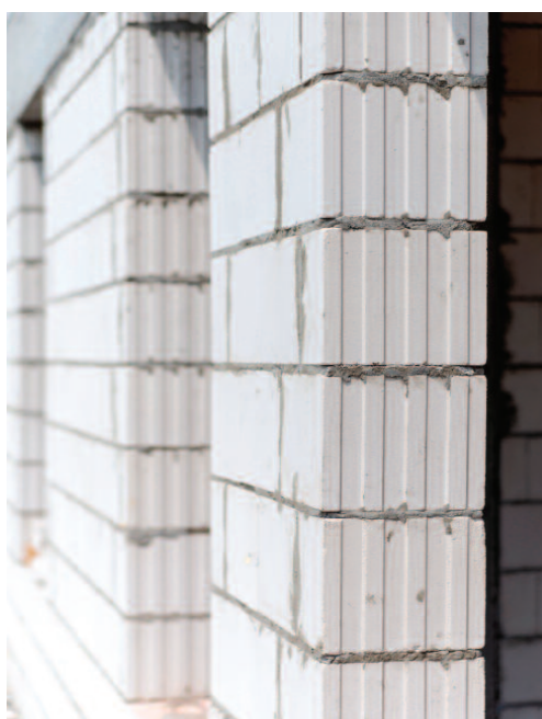
Ściana zewnętrzna wykonana z bloczków silikatowych
