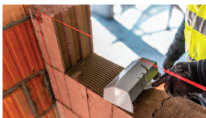
Wznoszenie ściany z bloczków wienerberger z zastosowaniem zaprawy cienkowarstwowej
