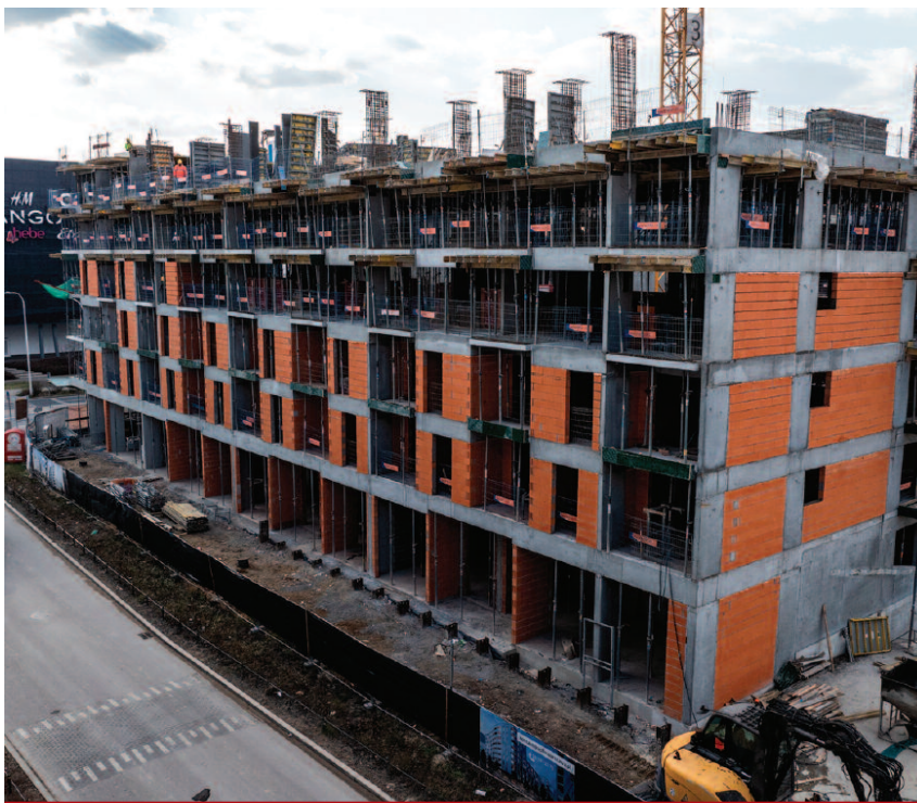
Budynek wielorodzinny, w którym ściany wykonano z pustaków i bloczków wienerberger
