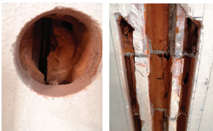
Photo 3. Examples of chasing of walls made of hollow bricks Fot. 3. Przykłady bruzdowania ścian wykonanych z cegieł drążonych
