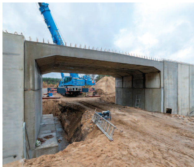
Fot. 4. Przykładowa konstrukcja wiaduktu kolejowego
