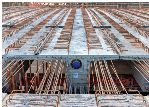
Fot. 2. Przykładowe sprężone, kablobetonowe belki mostowe
