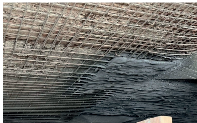
Photo 1. Spraying shotcrete during floor repair Fot. 1. Natrysk torkretu podczas naprawy stropu
