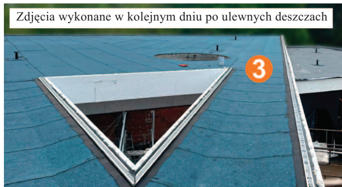
▲ Projekt odwodnienia i spadków eliptycznych, zoptymalizowany pod kątem skutecznego odprowadzenia wody oraz ilości zastosowanego materiału płyt spadkowych – Al
