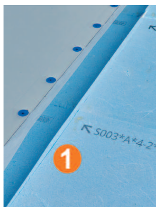
▲ Model 3D – spadki eliptyczne, strzałki wskazują miejsca lokalizacji wpustów dachowych
