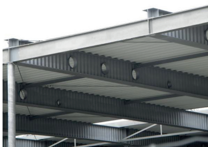
Photo. 1. Objects with girders with corrugated web with openings Photo: authors Fot. 1. Obiekt z dźwigarów o falistym środniku z otworami Fot. autorzy
