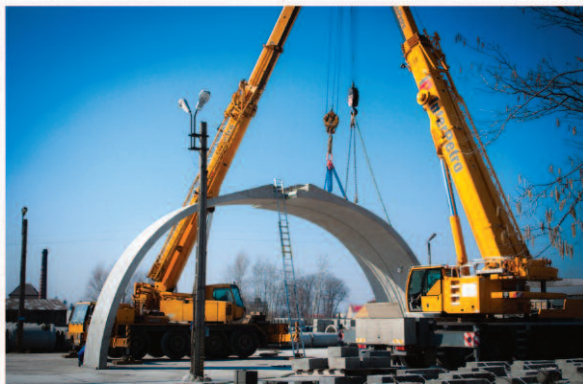
ZAKŁAD BETONÓW W KOLBUSZOWEJ - MONTAŻ ELEMENTÓW ŁUKOWYCH
