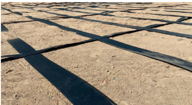
ArmaLynk® – geosiatki o ultrawysokiej wytrzymałości do wzmocnienia i stabilizacji podłoża przy budowie dróg, linii kolejowych, mostów, wiaduktów, platform roboczych
