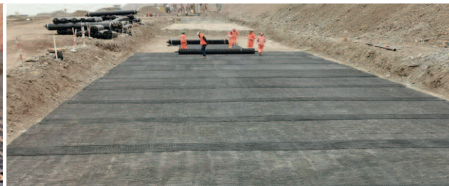
ArmaGrid® – jedno- lub dwukierunkowe siatki PP do wzmocnienia podłoża to wytrzymałość na rozciąganie do 300 KN/m, odporność na starzenie, agresję chemiczną i biologiczną
