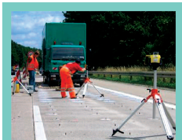
Niwelatory laserowe do kontroli wysokościowej
