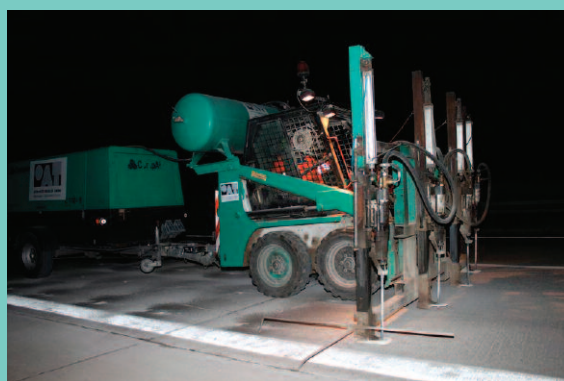
Wiercenie otworów w nawierzchni
