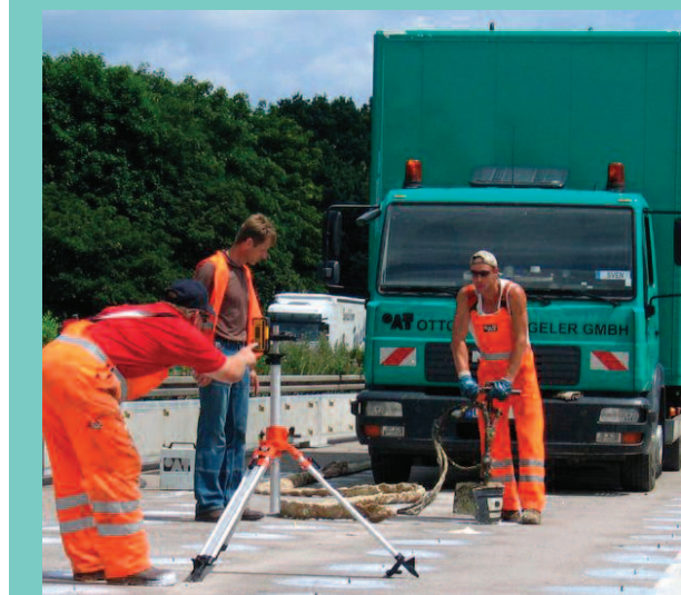
Kontrola położenia płyty podczas tłoczenia
