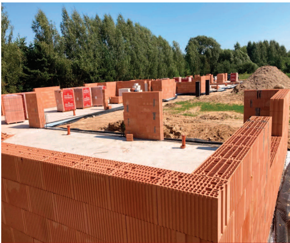
Ściany wznoszone z pustaków Porotherm Klima+
