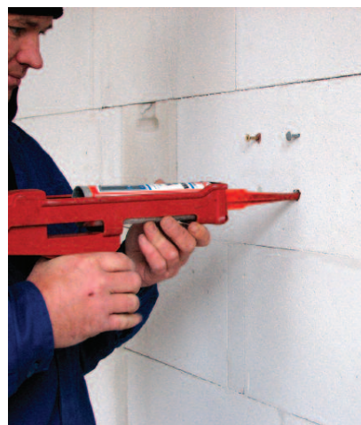
Fot. 4. Zastosowanie kotew chemicznych
