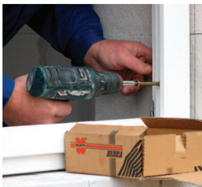
Fot. 3. Montaż stolarki przez ramę do muru z ABK za pomocą łączników wkręcanych AMO
