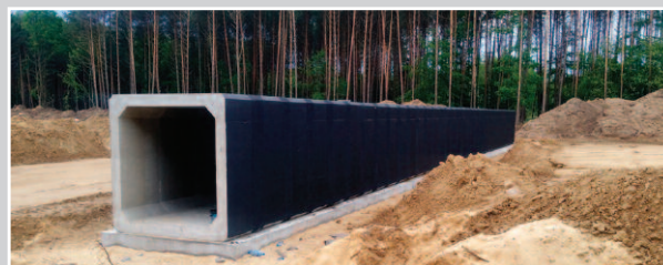
Fot. 4. Zmontowana w czasie 14 godzin konstrukcja prefabrykowanego przepustu skrzynkowego
