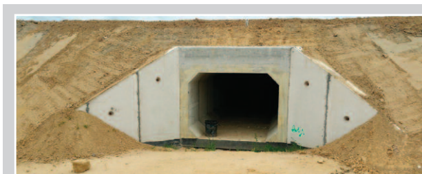
Fot. 3. Prefabrykowane wloty – skrzydła SK przepustu skrzynkowego
