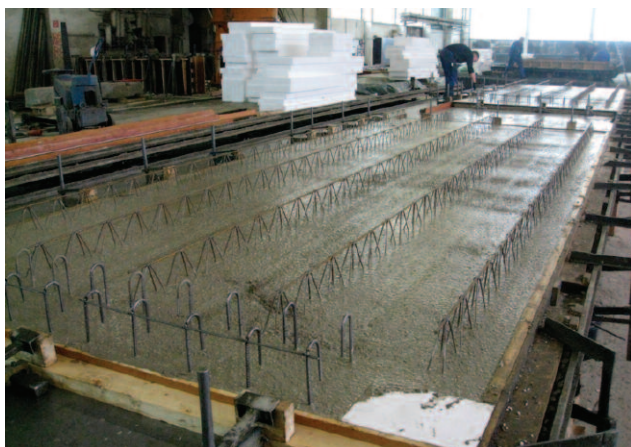
Fot. 1. Produkcja elementu prefabrykowanego z zastosowaniem plastyfikatora PCE + FastKick
