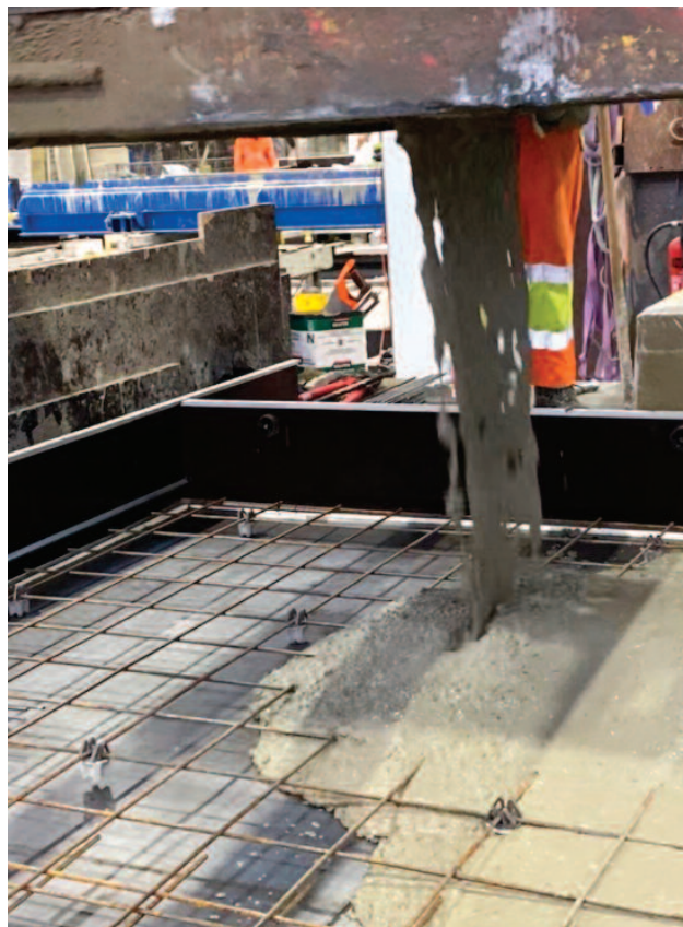
Fot. 3. Produkcja płyty prefabrykowanej wykonywanej z betonu samozagęszczalnego
