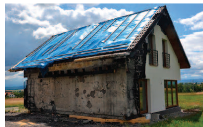
Fot. 1. Tymczasowe podparcie płyty fundamentowej budynku po pożarze
