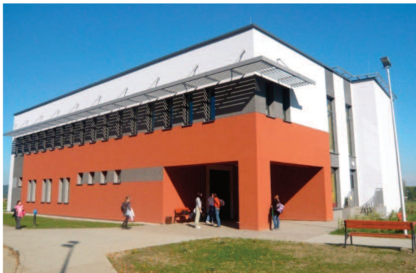
Szkoła w standardzie pasywnym w Budzowie Passive School Building in Budzow
