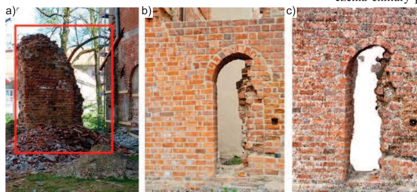
Fot. 4. Łuk: a) fragment ściany przed remontem; b) fragment ściany po remoncie; c) chmura punktów CP1_iPhone (429 989 punktów) Photo 4. The arch: a) the wall fragment before renovation; b) the wall fragment after renovation; c) CP1_iPhone point cloud (429 989 points)
