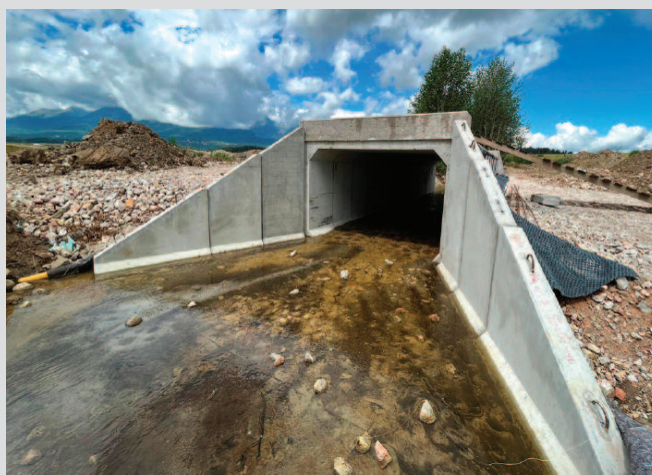
Prefabrykowane przepusty skrzynkowe i ścianki oporowe
