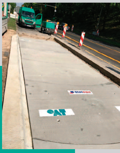
Fot. 1. Nawierzchnia z prefabrykatów o zaokrąglonych krawędziach Fot. OAT
