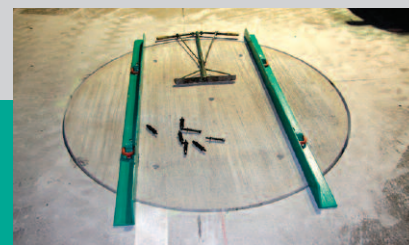
Fot. 2. Okrągły prefabrykat do naprawy uszkodzonych naroży płyt Fot. Otto Alie-Teigeler GmbH, Hambuehren, Niemcy
