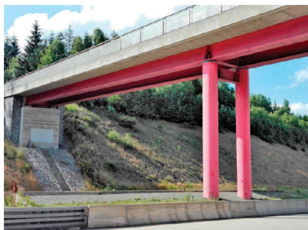
Przykład zastosowania słupów CFST w konstrukcji zespolonego stalowo-betonowego obiektu mostowego nad autostradą A93 między Hof i Ratzboną w Niemczech
