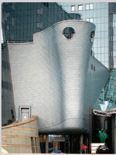
Fot. 1. Budynek TVP Warszawa – „Dziób okrętu” (uszczegółowiony projekt podkonstrukcji determinujący kształt i dobór pokrycia oraz częściowe wykonawstwo – Ryszard Klatt – 2005 r.)
