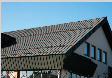
Fot. 2. Fragment pokrycia dachu
