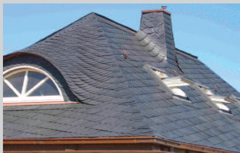
Fot. 1. Tylko pokrycia z płytek umożliwiają zbudowanie wysokiego wolego oka. W tym dachu płytki są kamienne – łupkowe
