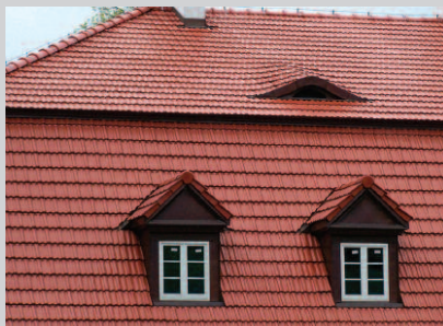
Fot. 2. Wole oka powstały w celu dobrego wentylowania poddasza i pokrycia dachu. Współcześnie takie zastosowanie jest już rzadkością
