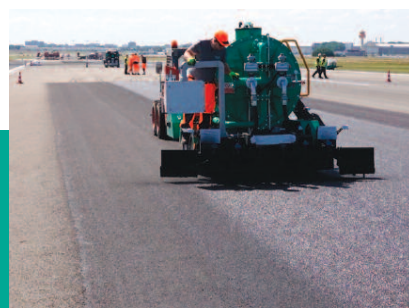
Fot. 4. Układanie warstwy ONYX® na nawierzchni lotniska w Hamburgu
