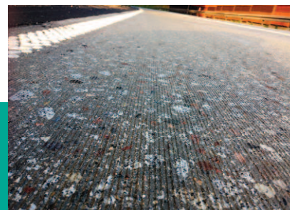
Fot. 2. Tekstura starej nawierzchni betonowej po wykonaniu zabiegu grindingu na drodze DK50 Młodzieszyn
