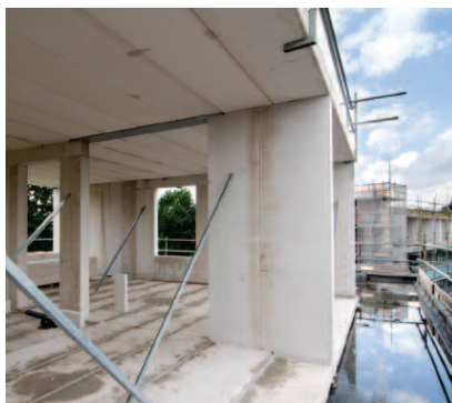
Ściany konstrukcyjne z modułowych paneli z ABK Fot. Xella Polska Sp. z o.o.
