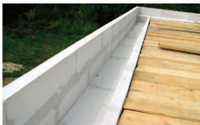
Fot. 3. Zastosowanie płytek w murach jednowarstwowych, jako elementu obudowy wieńca
