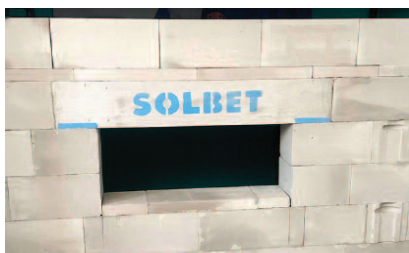
Fot. 2. Zastosowanie płytek jako warstwy wyrównującej wysokość kondygnacji oraz strefy pod parapetem
