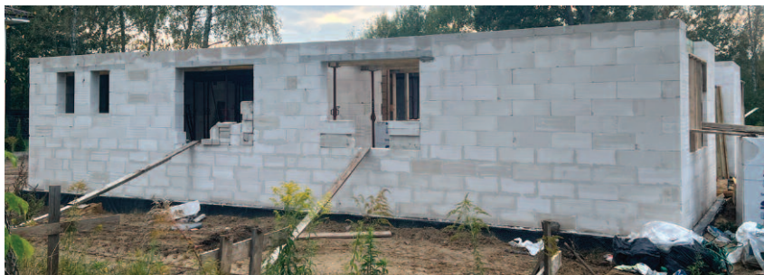
Fot. 1. Warstwa wyrównująca z bloczków ABK szerokości 120 mm w murze o grubości 24 cm
