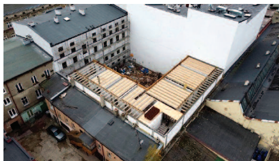
Fot. 8. Rozbudowa kamienicy w Łodzi
