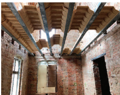
Fot. 7. Montaż stropu Rectolight
