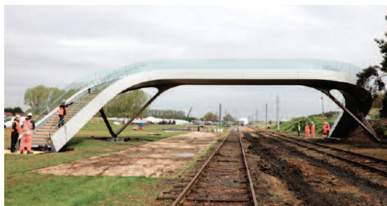
Fot. 3. Prototyp kładki FLOW Bridge, Longmarston, Warwickshire, W. Brytania, 2021 r. [12]
