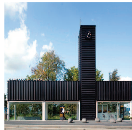
Fot. 4. Kontenerowa stacja Barneveld Noord (NL) – widok frontowy [17]
