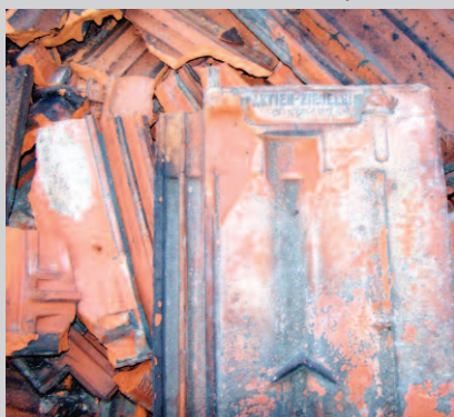
Fot. 3. Sterta dachówek w kontenerze ustawionym obok budynku, w przypadku którego dokonano wymiany pokrycia
