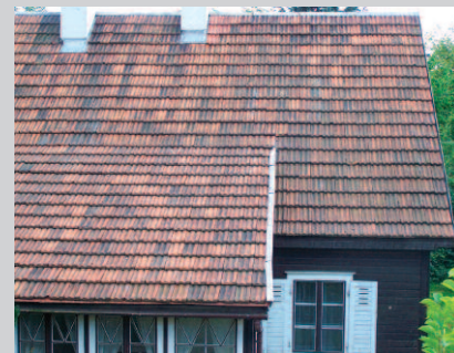
Fot. 2. Dach pokryty dachówką marsylką. Mimo że ma ponad 60 lat, nie widać na nim uszkodzonych dachówek
