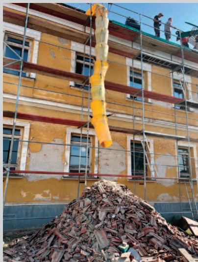
Fot. 5. Większość dachówek zrzuconych z dachu nadawała się do powtórnego ułożenia
