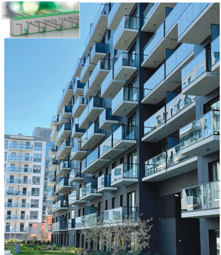
Fot. 1. Osiedle Kępa Mieszczańska, Wrocław, gdzie w miejscu połączenia ściany zewnętrznej z balkonem zastosowano łączniki izolacyjne ISOPRO®
