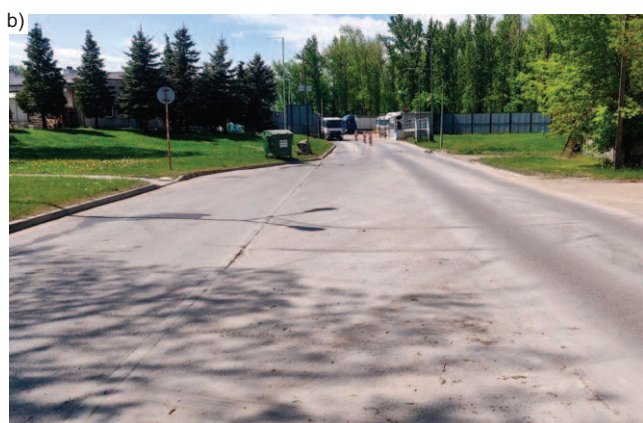
Fot. 2. Droga z nawierzchnią: a) asfaltową; b) betonową Fot. Autor Photo 2. Road with: a) an asphalt pavements; b) a concrete pavements Photo: Author
