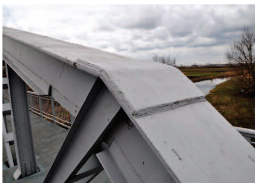
Fot. 7. Fragment mostu spawanego w Maurzycach z nakładką na pasie górnym
