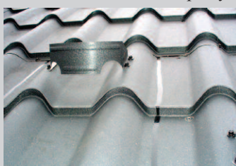
Fot. 2. Ilość skroplin pod niewentylowanymi pokryciami jest czasami tak duża, że wyciekają przez wszystkie większe szczeliny
