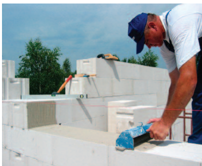
Fot. 6. Do murowania na cienkiej spoinie należy stosować odpowiednie kielnie
