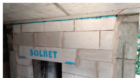
Fot. 7. Szczeliny podstropowe nad ścianami wypełniającymi należy starannie wypełnić odpowiednim trwale elastycznym materiałem, spełniającym wymagania izolacyjności cieplnej, ogniowej i akustycznej oraz szczelności
