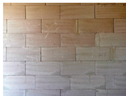
Fot. 2. Prawidłowo wykonany mur ma przewiązania co najmniej 0,4 wysokości elementów lub 40 mm (decyduje większa wartość). W murach na cienkich spoinach ich grubość nie może przekraczać 3 mm. Spoin pionowych (czołowych) można nie wypełniać zaprawą jedynie wówczas, gdy oba łączone elementy mają odpowiednio profilowane powierzchnie czołowe
