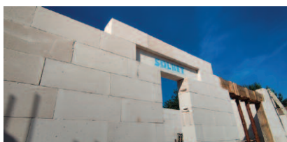
Fot. 4. Nadproża prefabrykowane z ABK i żelbetowe wykonywane w szalunkach
