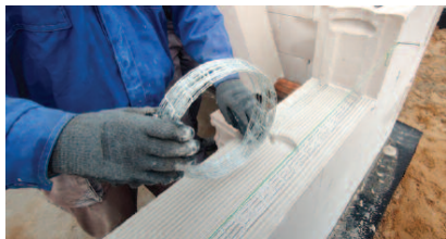
Fot. 3. Zbrojenie muru w strefie podokiennej
