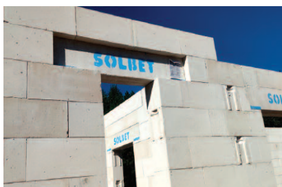
Fot. 5. Prawidłowe ułożenie nadproży prefabrykowanych, minimalna długość podparcia oznaczona linią niebieską. Lico nadproża cofnięte w stosunku do lica muru umożliwia ułożenie dodatkowej warstwy termoizolacji
