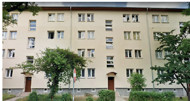
Fot. 5. Budynek mieszkalny wielorodzinny we Wrocławiu Photo 5. Multi-family residential building in Wrocław
